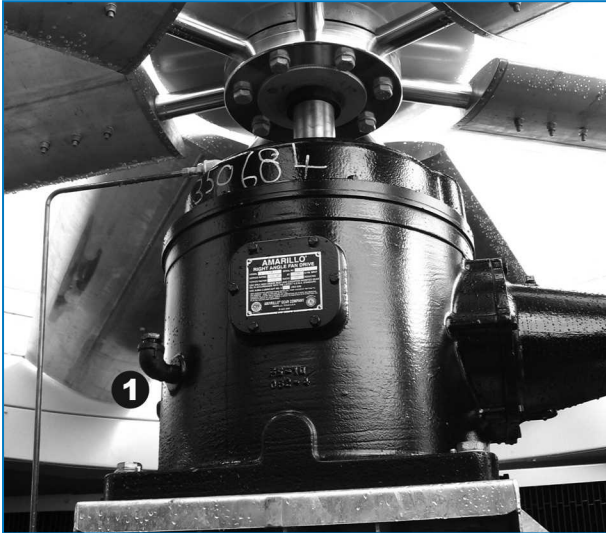
Getriebe mit einfacher Übersetzung
