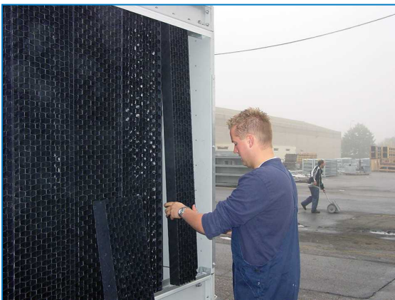
Kombinierte Lufteintrittsschutzelemente entfernen
