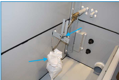
Befestigung und Umhüllung der Schwimmerkugel
