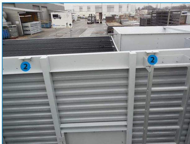
2. Guida/staffa per il montaggio della sezione inferiore
