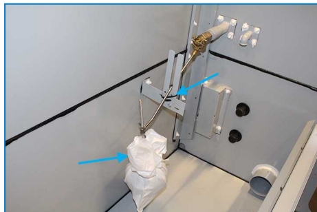
Fissaggio e avvolgimento della palla galleggiante
