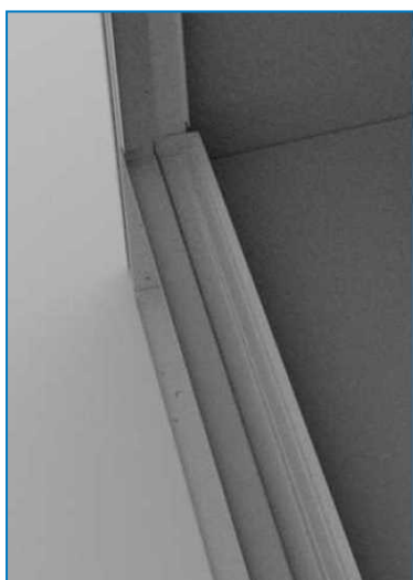
Grondaia di raccolta dell'acqua
