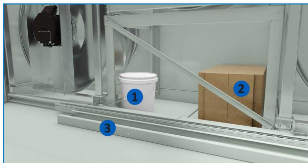
Emplacement de la visserie, de la pompe et du support de pompe (en cas d'expédition séparée)
