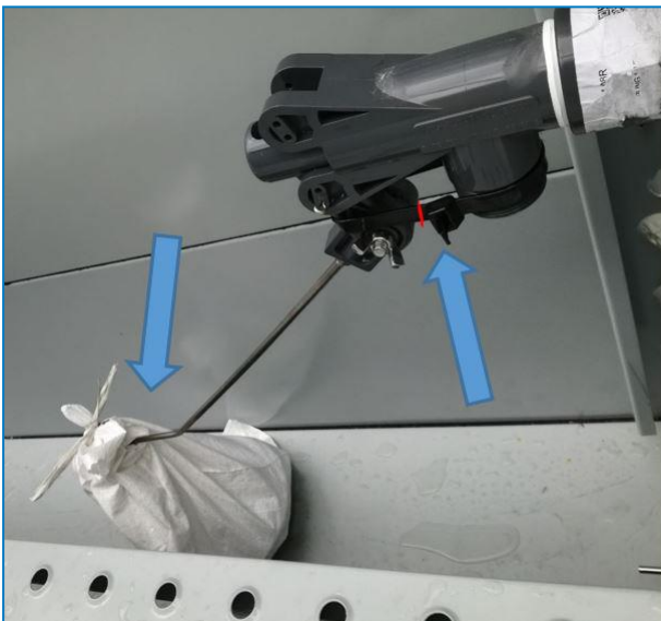
Fijación y envoltura del flotador de bola
