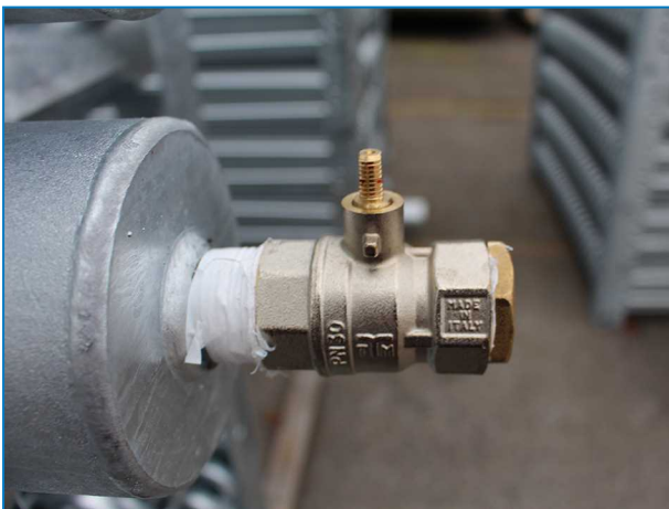
Conexión superior de la batería con válvula de alivio de presión en torres de enfriamiento de circuito cerrado y conexiones superiores a ND 100.
