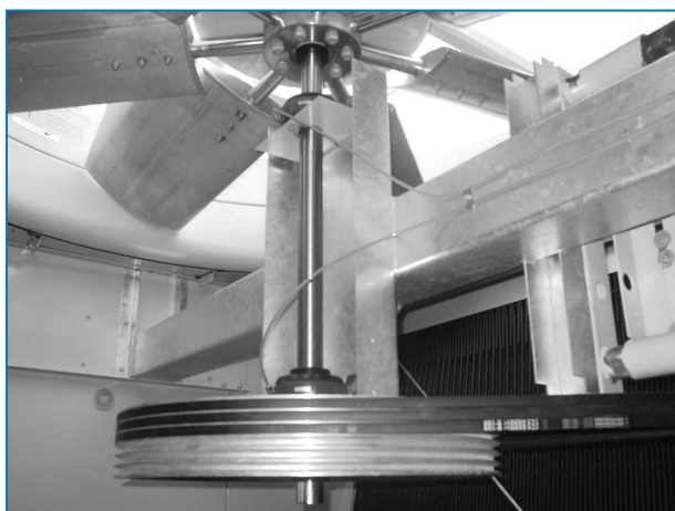
Вал вентилятора
